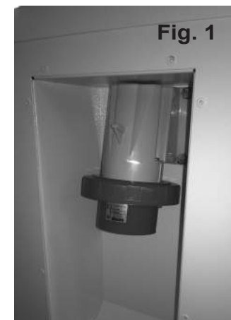
Fig. 1 Prise CEE 32 A, 5 pôles, 400 V
